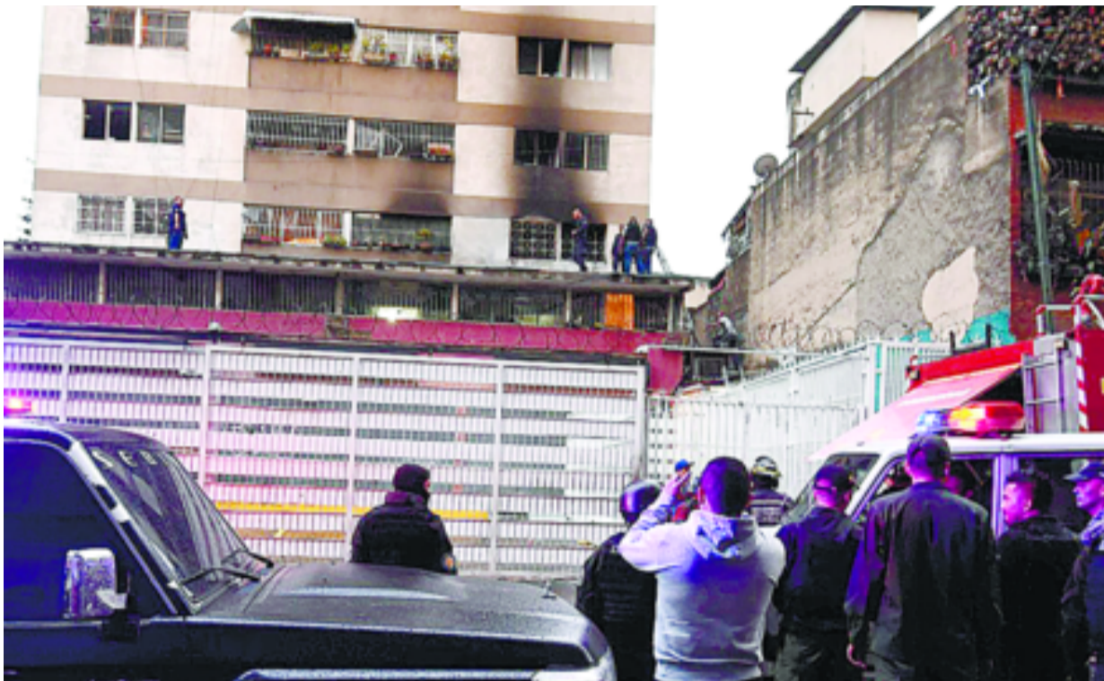
8月5日,加拉加斯,委内瑞拉安全部门对在爆炸中受损的建筑进行调查。
