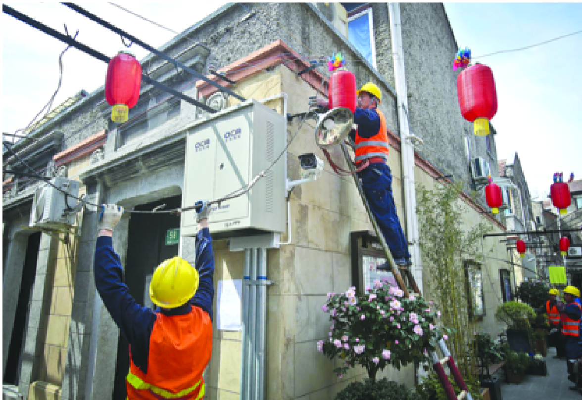
昨日,施工人员在西成里小区拆除信号架空线
