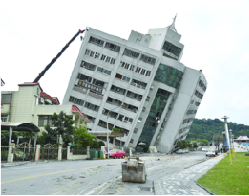
地震后倾斜倒塌的云门翠堤大楼(2月7日摄) /新华社
